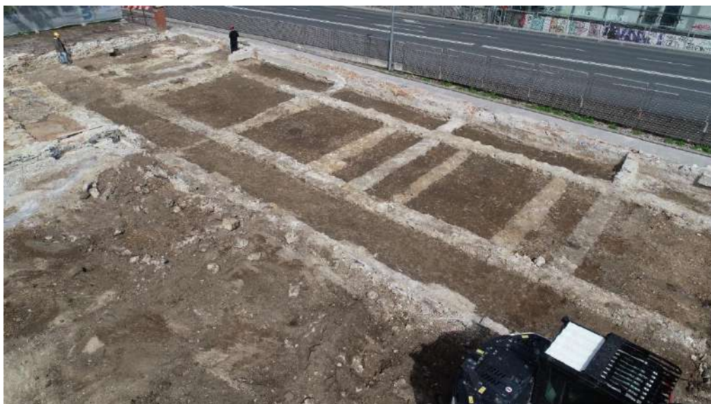
SLIKA 59: POGLED NA SE 1002 MED TEMELJI OBJEKTA 1 NA SEVERNEM DELU (POGLED PROTI SV)
