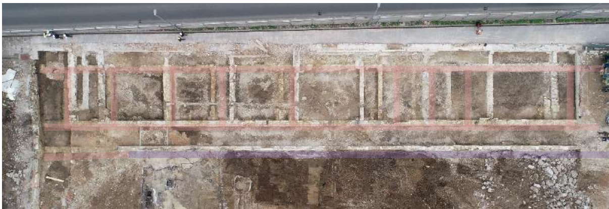
SLIKA 105: ZIDovi IN TEMELJI SEVERNEGA DELA VZHODNEGA KRAKA STAVBE. VIDNI ZIDovi FAZE 3A (ROZA), 3B (VIJOLIČNA) IN 4. FAZE (NEOBARVANO) (POGLED PROTI V)
