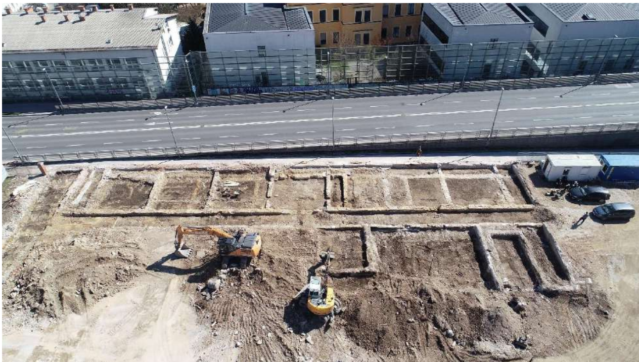
SLIKA 4: RAZISKAVE OB GRADNJI (POGLED PROTI V)
