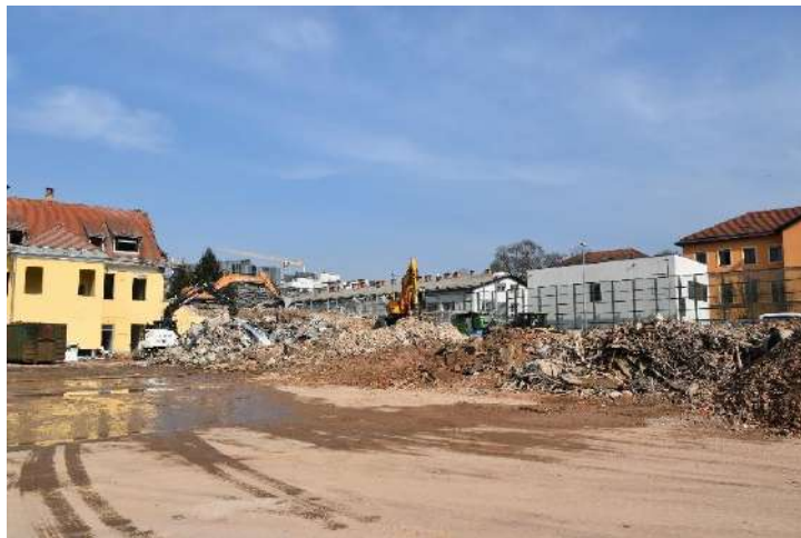
SLIKA 3: RUŠENJE OBJEKTA (POGLED PROTI SV)
