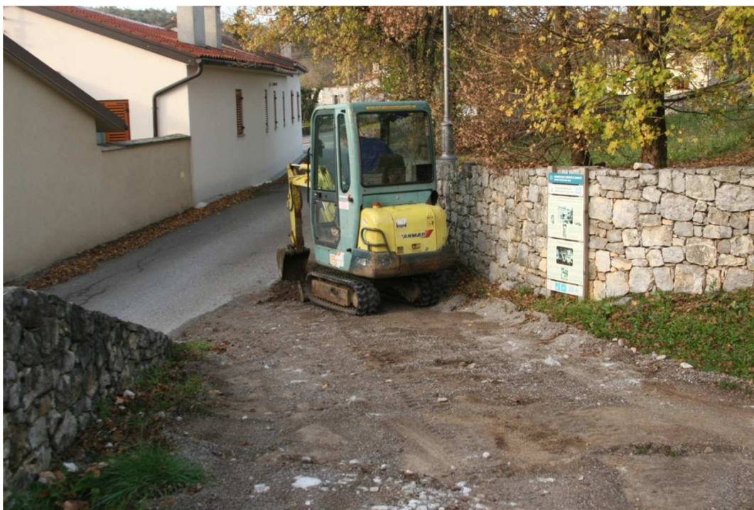
Sl. 4: Priprava peščenega dovoza za tlakovanje v središču vasi Matavun (Foto: J. Rupnik)
