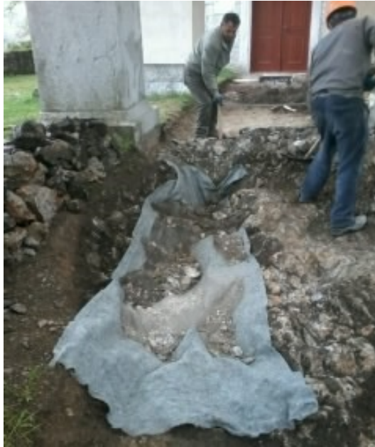
Sl. 12. Zasipavanje geotekstila pred zvonikom. Na celotnem območju prenove je bil geotekstil položen na nivo, do katerega so segli tokratni posegi. (foto: T.L.).
