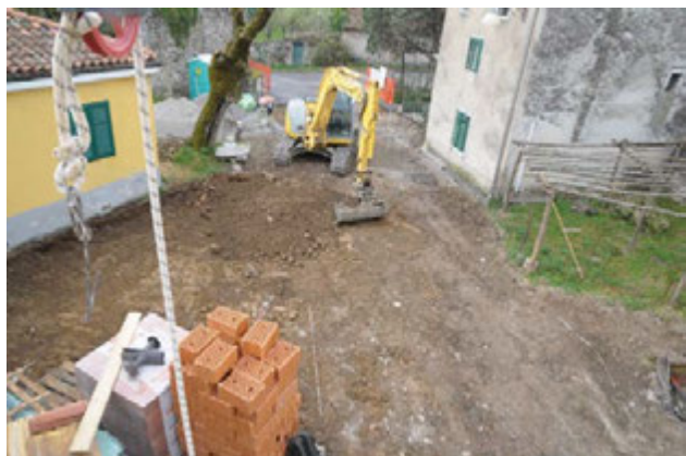
Sl. 18. Osrednji del trga ob odstranjevanju modernega nasutja (foto: J.S.).
