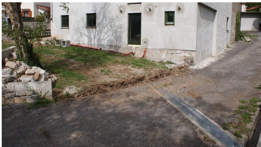
Sl. 16: Pogled na izkop za temelj suhega zidu, pogled proti SZ.
