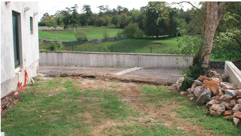
Sl. 1: Izkop za temelj suhega zidu na parc. št. 957/43 in 580/13 k.o. Naklo, v ozadju vrtača. Pogled proti V.
