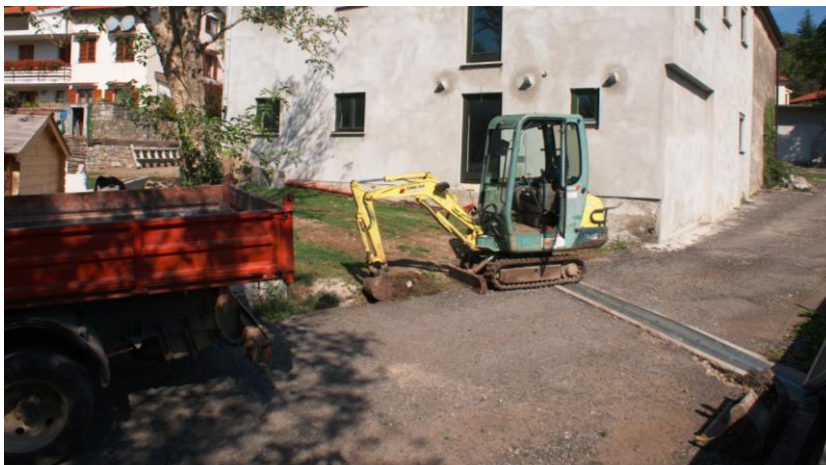
Sl. 6: Izkop za temelj suhega zidu na parc. št. 957/43 in 580/13 k.o. Naklo.
