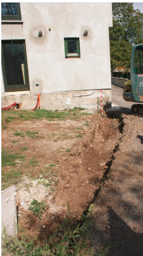
Sl. 17: Izkop za temelj suhega zidu na parc. št. 957/43 in 580/13 k.o. Naklo.
