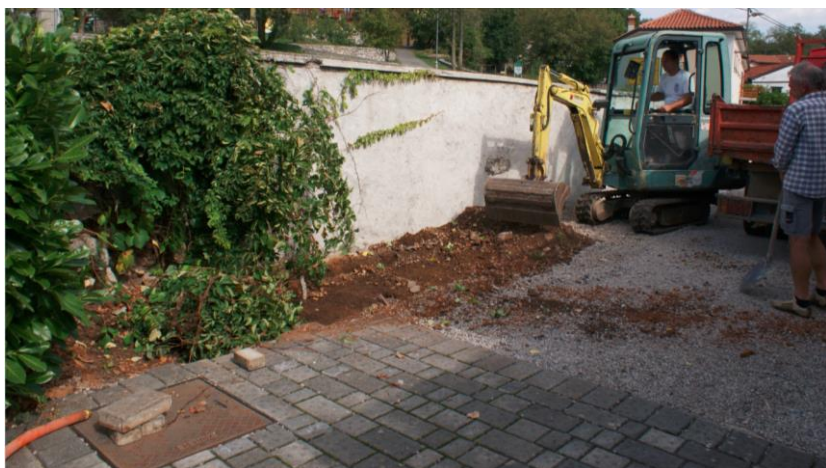
Sl. 18: Izkop na parc. št. 580/8 k.o. Naklo za potrebe tlakovanja dvorišča.
