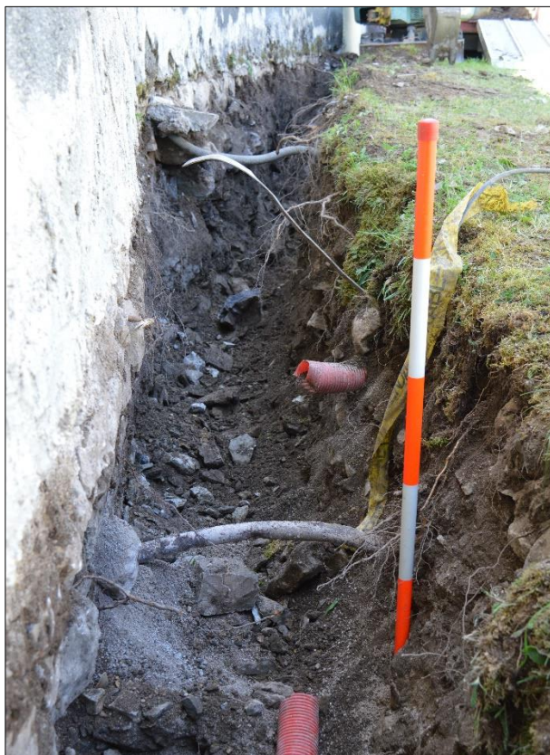
Slika 11: Telefonska, vodovodna in električna napeljava v osrednjem delu izkopa (foto: U. Košir, 2017).
