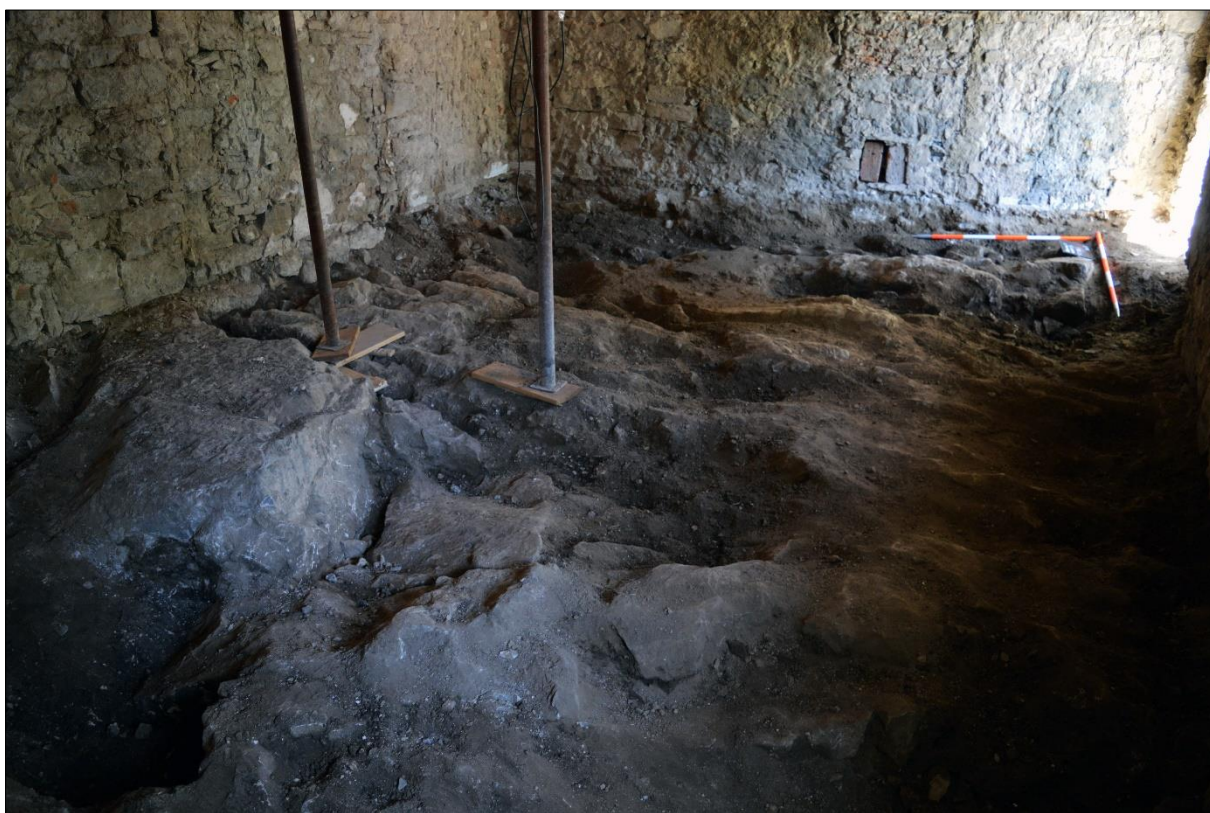
Slika 1: Pogled na notranjost objekta B (foto: U. Košir, 2017).
