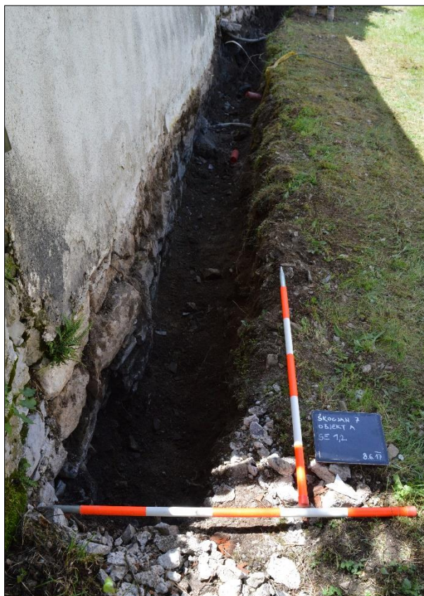
Slika 8: Vzhodni del izkopa ob objektu A (foto: U. Košir, 2017).
