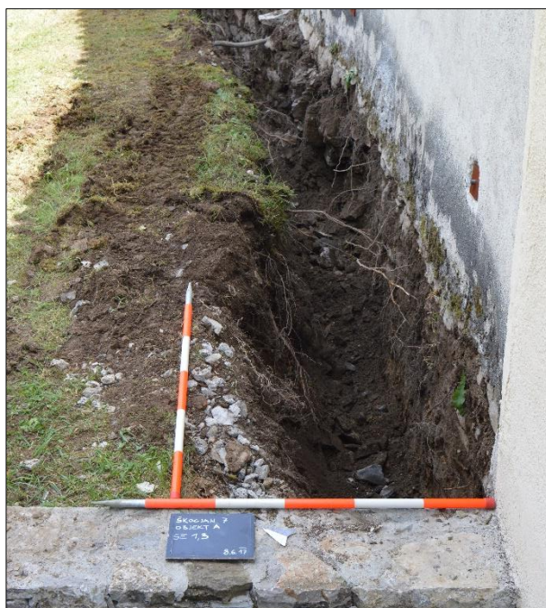
Slika 12: Zabodni del izkopa ob objektu A (foto: U. Košir, 2017).
