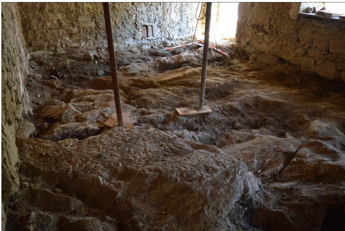
Slika 21: Vzhodni del objekta B po končanem delu (foto: U. Košir, 2017).
