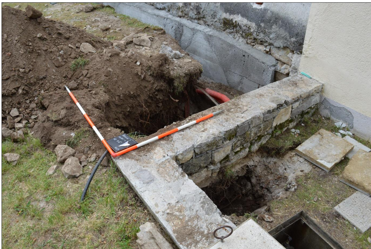
Slika 14: Dodatna izkopa v zahodnem delu (foto: U. Košir, 2017).
