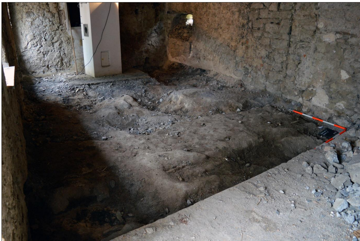
Slika 6: Notranjost objekta B pred začetkom dokumentiranja (foto: U. Košir, 2017).
