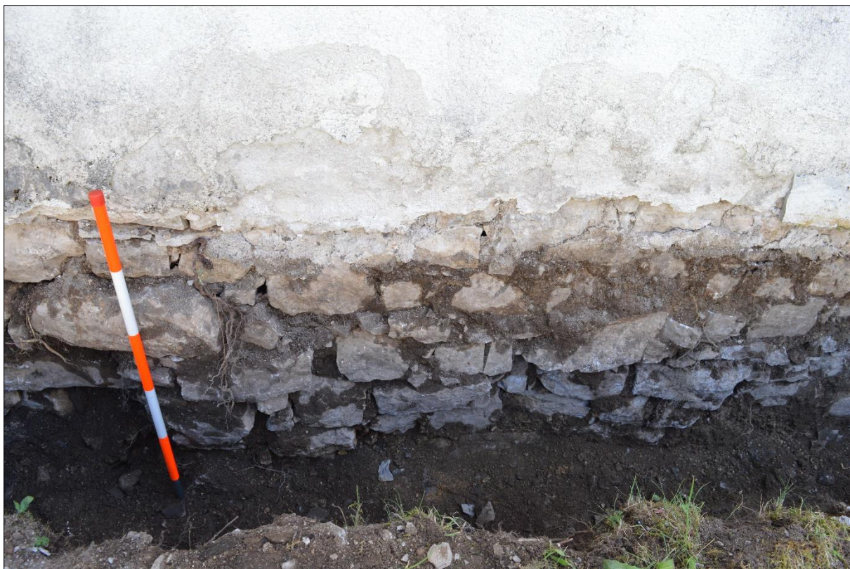
Slika 9: Temelj objekta A (foto: U. Košir, 2017).
