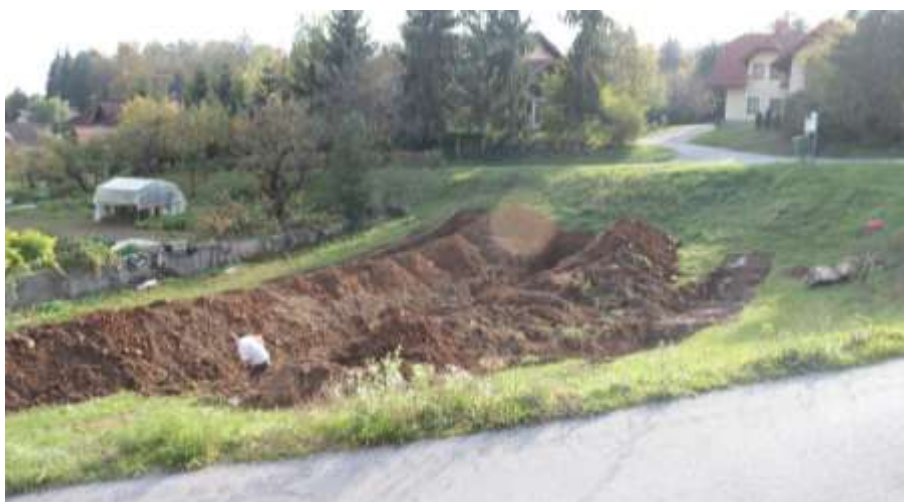
Sl. 3: Pogled proti jugozahodu na obravnavano območje med izkopom TJ (foto: S. Porenta).
