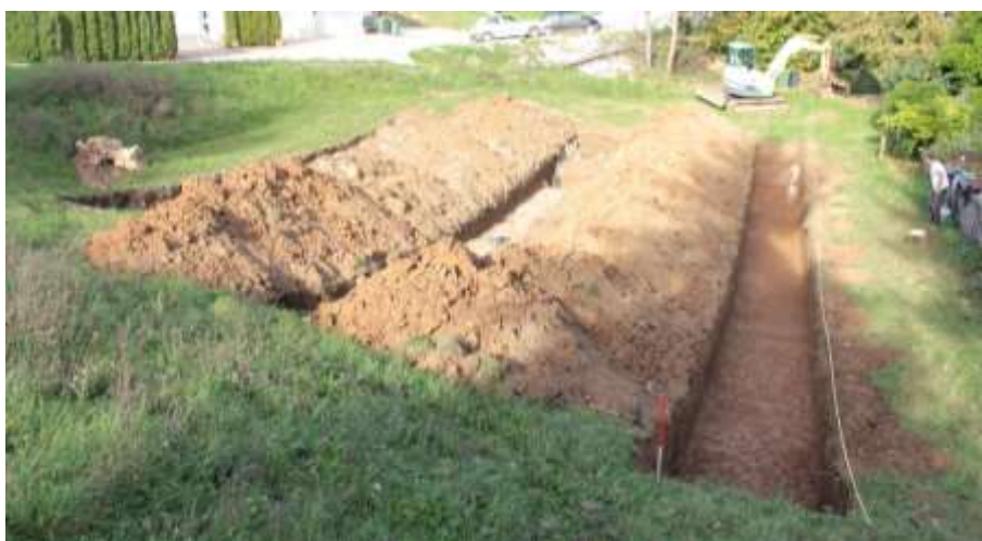
Sl. 2: Pogled proti severovzhodu na obravnavano območje med izkopom TJ (foto: S. Porenta).
