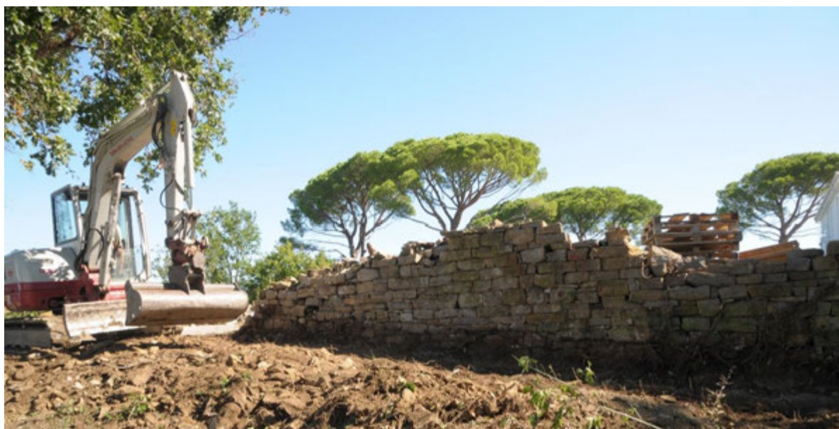
SLIKA 25: JUŽNI DEL ZAHODNEGA PODPORNEGA ZIDU – ŠKARPE 2 PRED RUŠENJEM.
