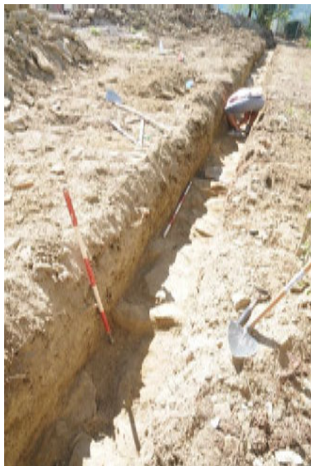
SLIKA 22: ČIŠČENJE ZADNJE LINIJE KAMNOV IZKOPANEGA TEMELJA ŠKARPE 1 – POGLED PROTI ZAHODU.
