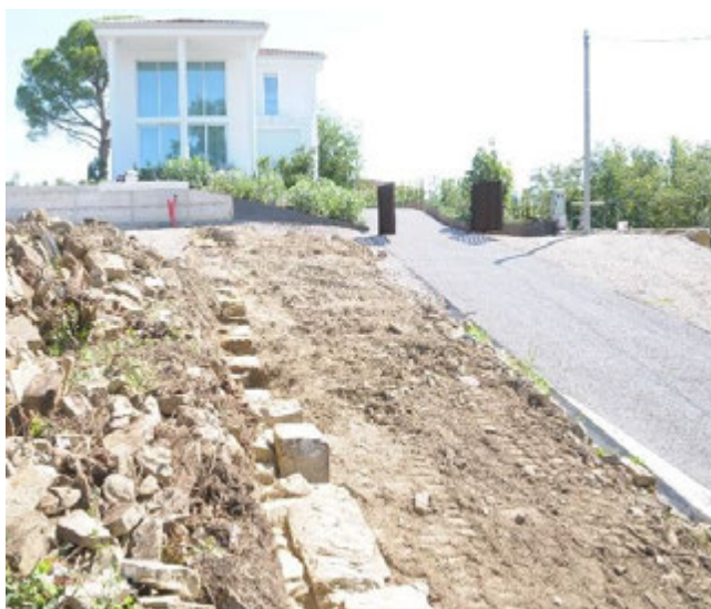
SLIKA 36: VZHODNI DEL JUŽNEGA PODPORNEGA ZIDU – ŠKARPE 3 PO RUŠENJU – PUŠČENE VEČJE SKALE NA SKRAJNEM VZHODNEM DELU, POGLED PROTI VZHODU
