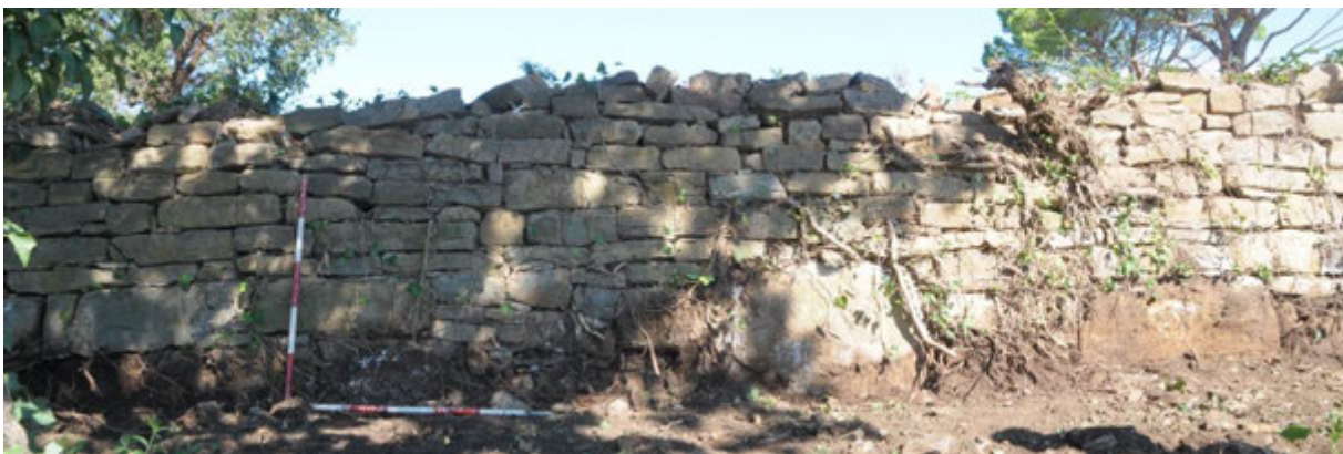
SLIKA 33: LICE JUŽNEGA PODPORNEGA ZIDU – ŠKARPE 3 - DETAJL NA OSREDNJEGA DELA.
