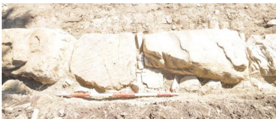
SLIKA 35: JUŽNI PODPORN ZID PO RUŠENJU – PUŠČENE VEČJE SKALE NA SKRAJNEM VZHODNEM DELU Z NOTRANJIM POLNILOM MANJŠIH KAMNOV. POGLED PROTI JUGU.
