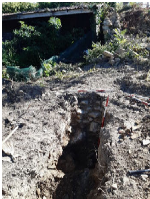
SLIKA 16: SONDA 1 – PRESEKANI TEMELJI ŠKARPE 1 – P1.
