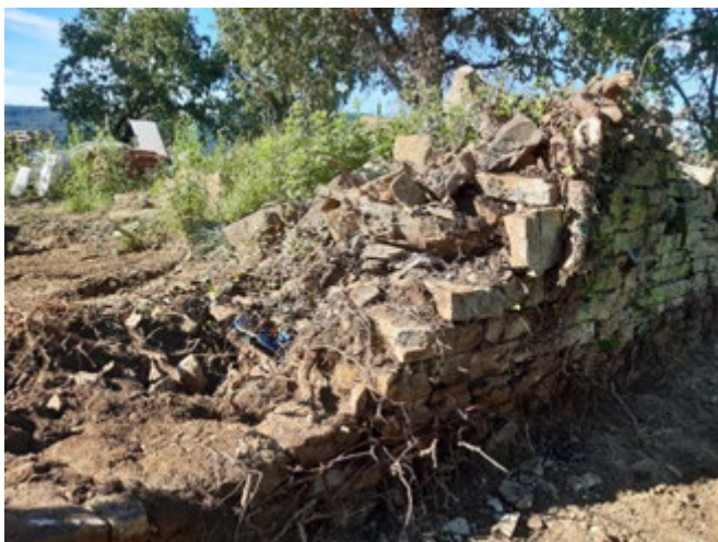
SLIKA 14: SEVERNI PODPORN ZID – ŠKARPA 1 V VIŠJEM ZAHODNEM DELU PRED IN MED RUŠENJEM.
