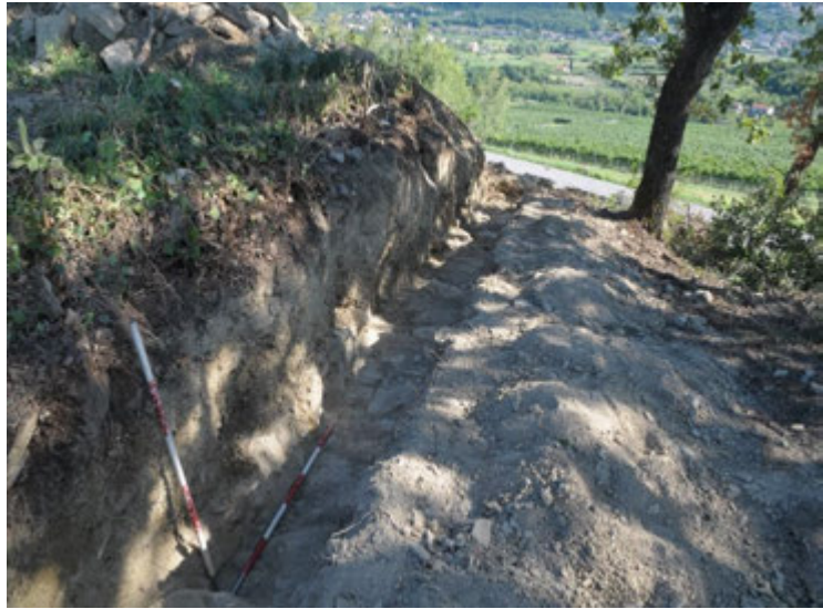
SLIKA 29: JUŽNI DEL ŠKARPE 2 – STOPNIČAST PADEC – POGLED PROTI JUGU.
