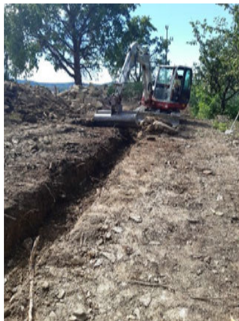
SLIKA 15: ŠKARPA 1 – RUŠENJE IN IZKOP TEMELJA
