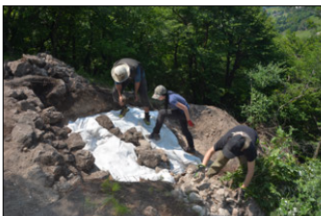
Slika 2.3: Sanacija izkopnega polja se je začela s prekrivanjem z geotekstilom in njegovim oblaganjem s kamni. 18. 6. 2021 (foto: A. Gaspari; DSC_9780)
