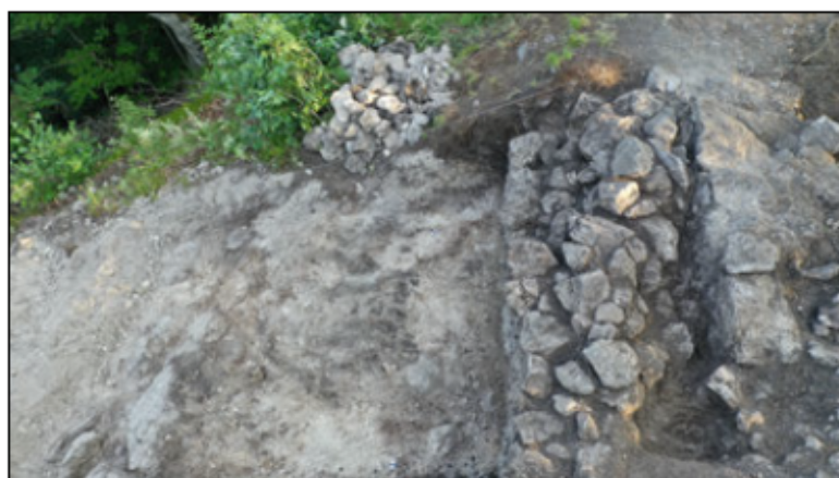
Slika 3.14: Delovna površina za gradnjo zidnega plašča z lisami oglja in koreninskih spletov. Desno stik med zidnim plaščem (SE 0011) in temeljem osrednje stavbe (SE 0003). Pogled proti zahodu. 18. 6. 2021 (foto: A. Gaspari; DJI_0830)
