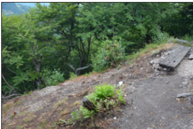
Slika 2.5: Sanacija se je zaključila z nasipanjem predhodno izkopanega humusa in nameščanjem kosov shranjene travne ruše. 18. 6. 2021 (foto: A. Gaspari; DSC_9785)
