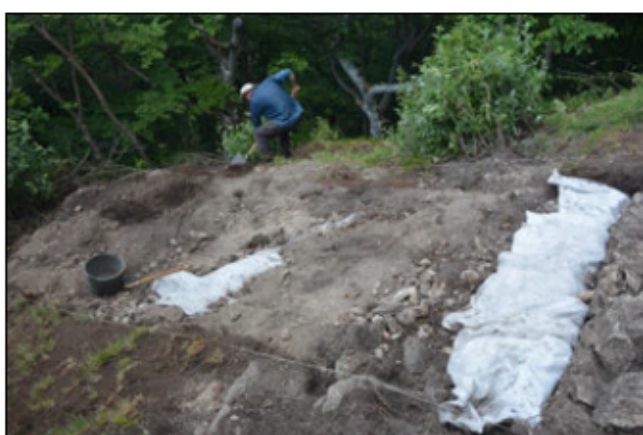
Slika 2.4: Sledilo je nasipanje dolomitnega drobirja 18. 6. 2021 (foto: A. Gaspari; DSC_9783)
