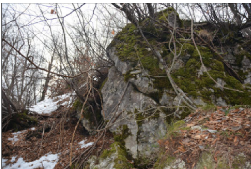
Slika 6.3: Odprta mlajša razpoka med kompaktnima blokoma močno tektoniziranega dolomita severno od vrha. Starejše razpoke, ob katerih je bila kamnina tektonizirana, so že zacementirane, zato je kamnina spet kompaktna (foto: A. Gaspari; DSC_0646)
