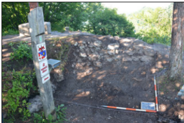
Slika 3.2: Površina vzhodne polovice izkopnega polja ob začetku čiščenja izdanjajočih kamnov temelja (SE 0003). Pogled od severovzhoda. 15. 6. 2021 (foto: B. Kumer; DSC_9327)
