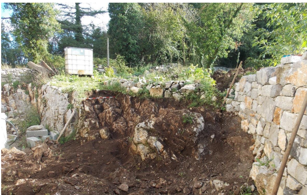
Sl. 7: Pogled na lokacijo raziskave na parc. št. 698/5 k.o. Naklo, izkop za letno kuhinjo; pogled proti Z.
