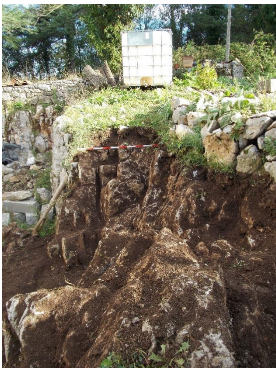
Sl. 16: Pogled na razgibano skalno osnovo z veliko razpokami - škrapljami. V ozadju je viden rob gradbenega izkopa za hišo Matavun 3C s poklesano skalo za izravnavo platoja na katerem stoji hiša.
