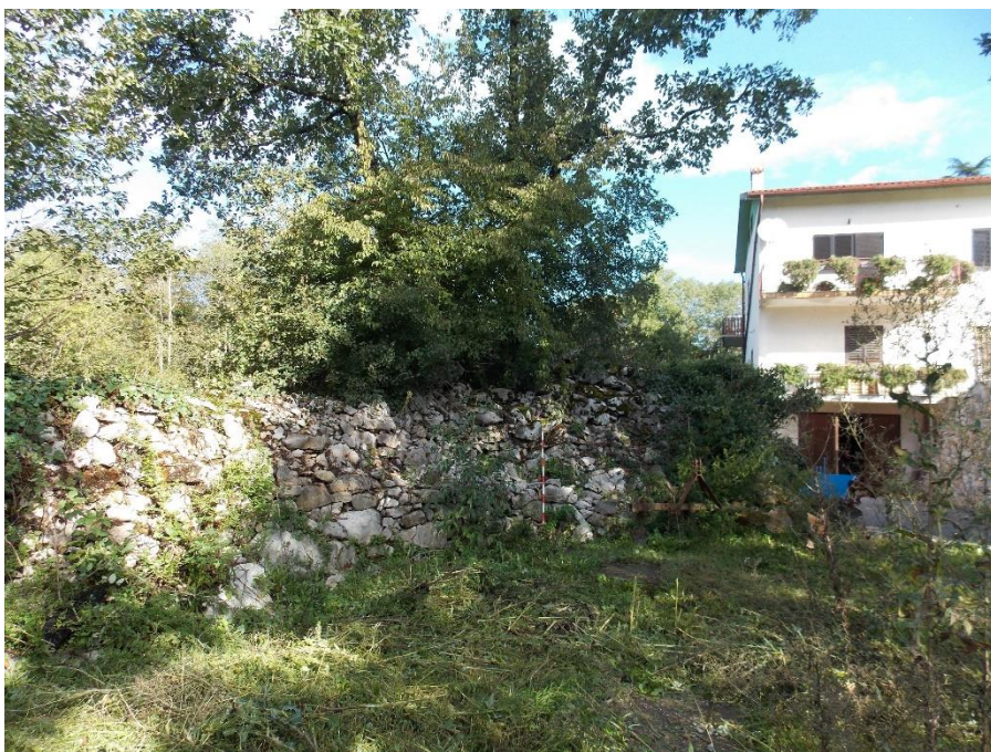
Sl. 9: Kamnito grublje pred posegom, pogled proti SZ.
