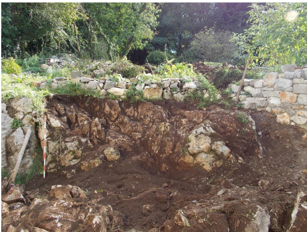
Sl. 15: Izkop na parc. št. 698/5 k.o. Naklo.
