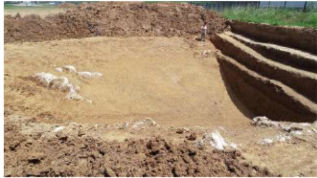
SLIKA 26: SE 1513 V VRTAČI 3 (POGLED PROTI V)
