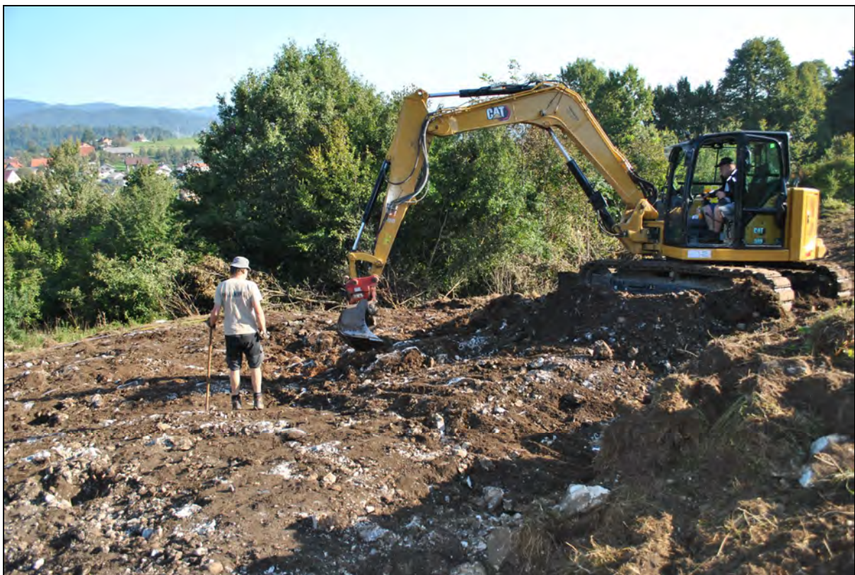
SLIKA 4.3 Strojni izkop vrhnjih plasti.
