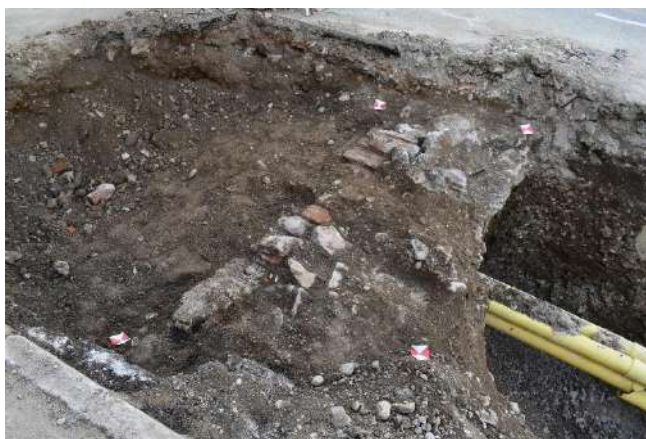
Slika 32: Moderen vkop za kanalizacijo SE 1107, zapolnjen z opekami in lomljenci, vezanimi z malto (SE 1106)
