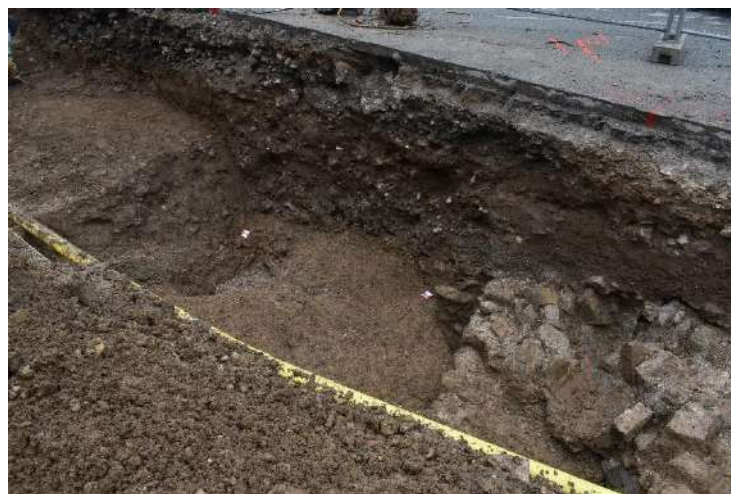
Slika 26: Apnenica 1038 je ležala le 2 m zahodno od zidu 1018Z
