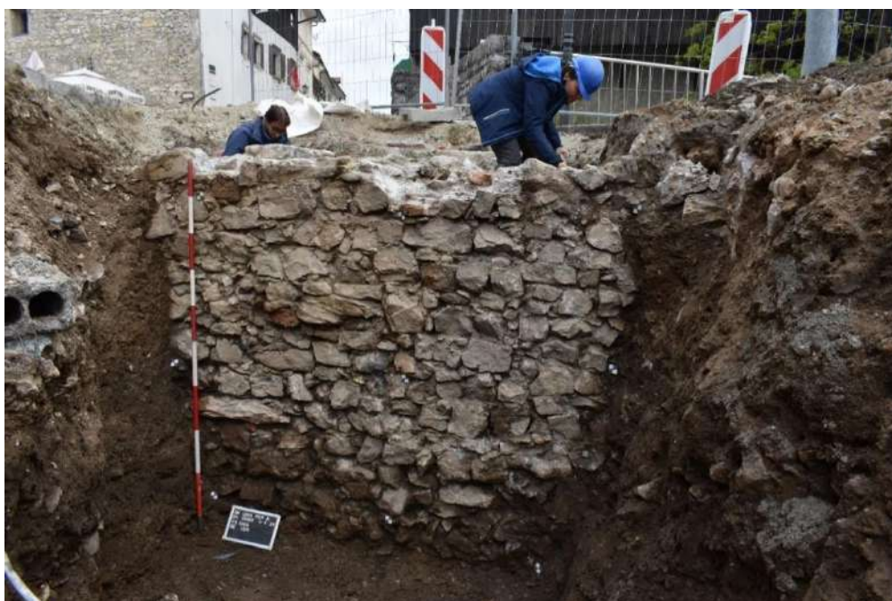
Slika 35: Pogled na zid SE 1125 (proti S)
