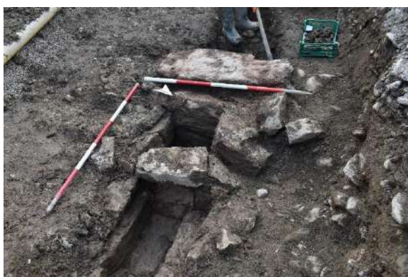
Slika 27: Kaskadni jašek SE 1007 nad kanalom 3 (Pogled proti JZ)
