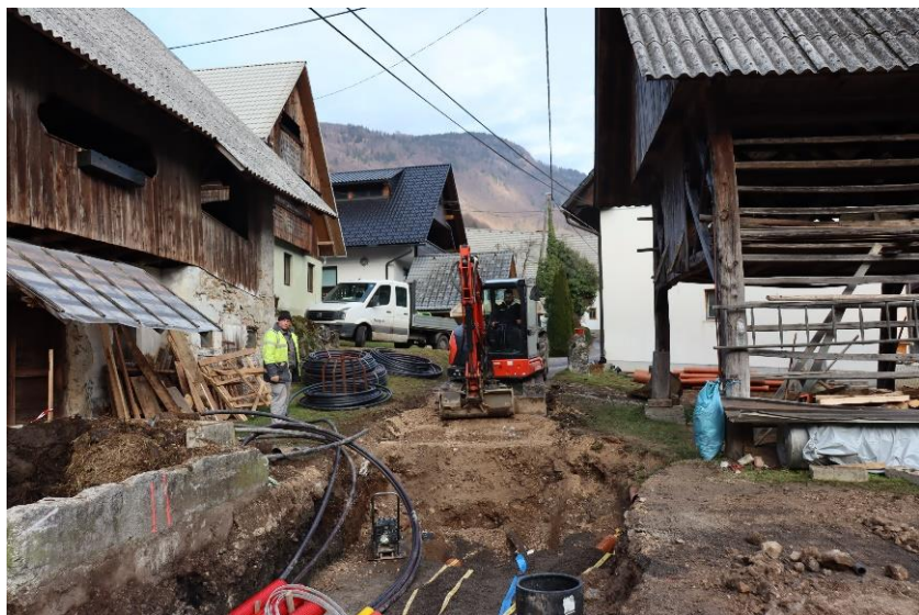
Slika 2.3: Potek gradnje komunalnih vodov po vaški cesti pod Studorom.
