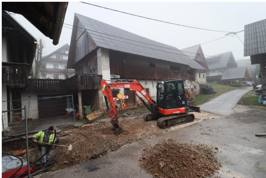
Slika 3.2.1: Odstranjevanje zgornji plasti pri hišni številki Studor 5.
